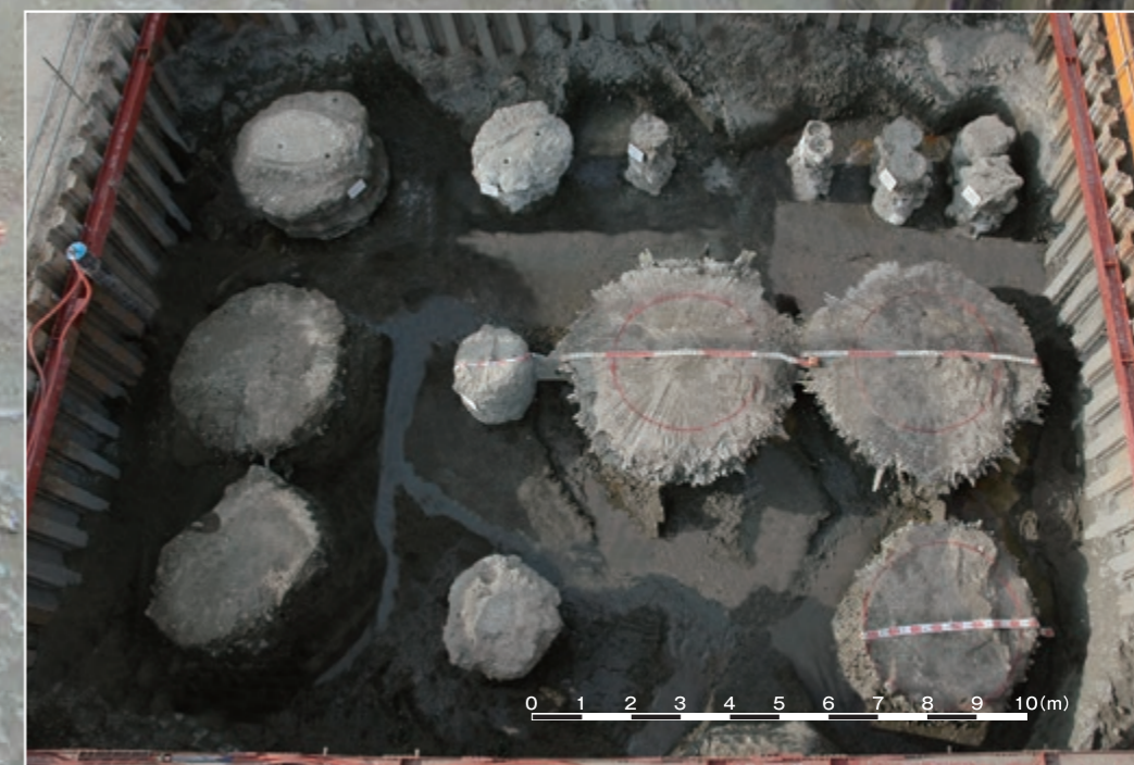
改良体出来形確認試験の状況
