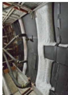
シールド貼付凍結管による凍結状況
