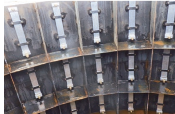
ICチャンネル設置状況
