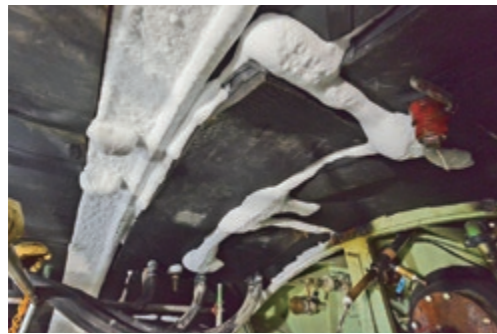
貼付凍結管による凍土
