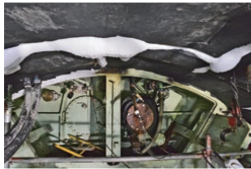
貼付凍結管による凍土
