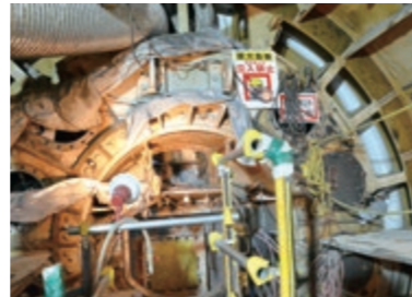
シールド到達側凍結状況
