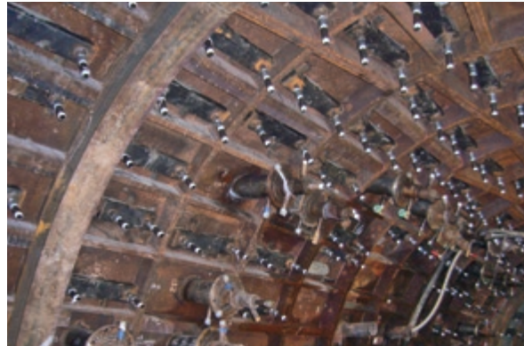
従来型貼付け凍結管設置状況
