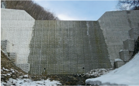
施工後の堰堤全景
