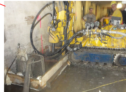
削孔箇所の拡大
