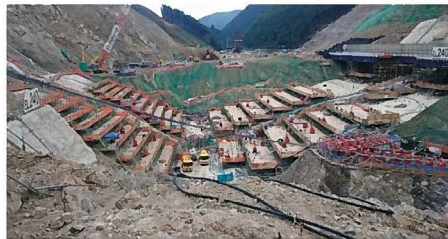
小石原川ダム
