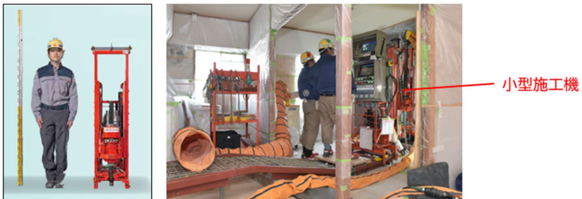
図 5 建物屋内での施工ができる小型施工機
