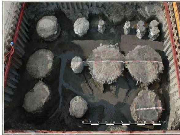
図1 実験工事における JETCRETE 改良体の例
