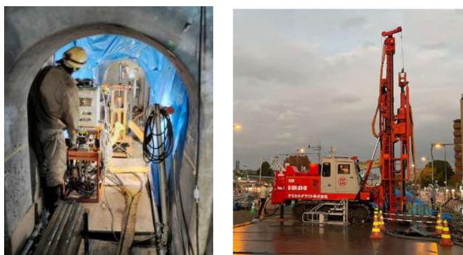
図6 JETCRETE 施工機の例
