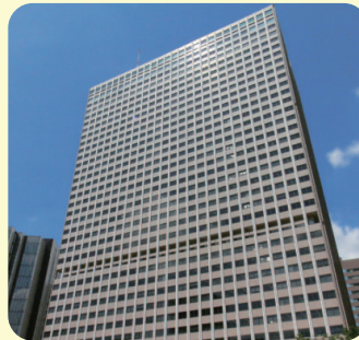
本社(日本初の超高層ビル「霞が関ビルディング」)
