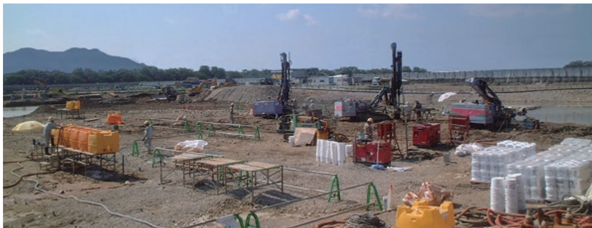
水素徐放剤注入状況
