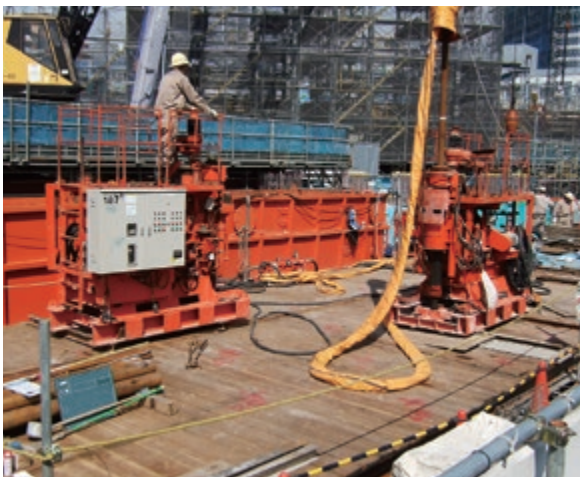
噴射攪拌施工状況
