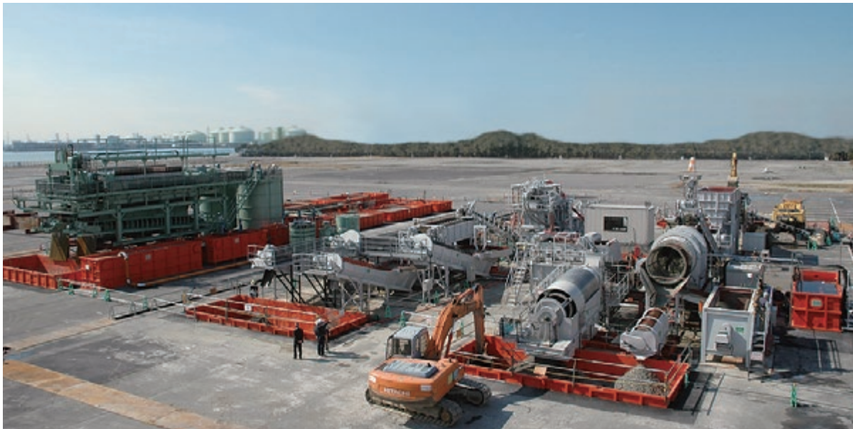
土壌洗浄プラント設置状況
