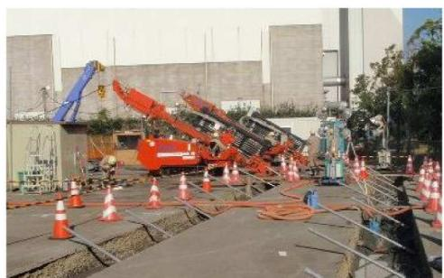
写真-2 削孔・注入管設置状況
