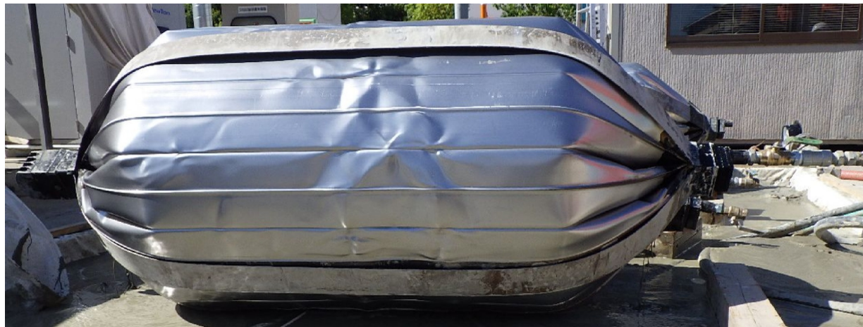
BB (バルーンボディ) 加圧完了状況
